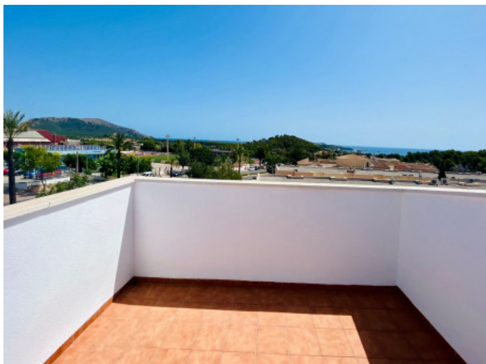
Terraza en la azotea
