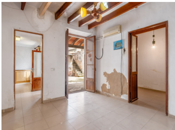
Cocina y salida al patio
