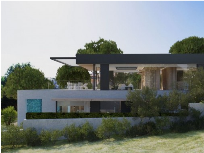
Vista exterior de la villa
