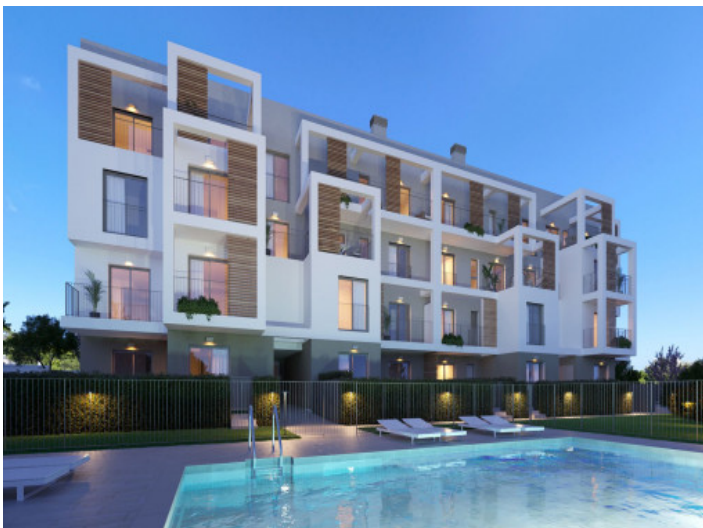
Piscina y fachada
