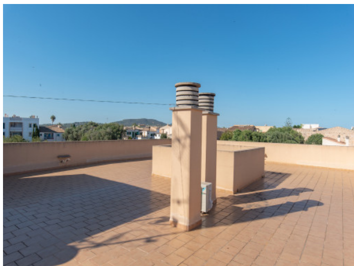
Grande azotea comunitaria
