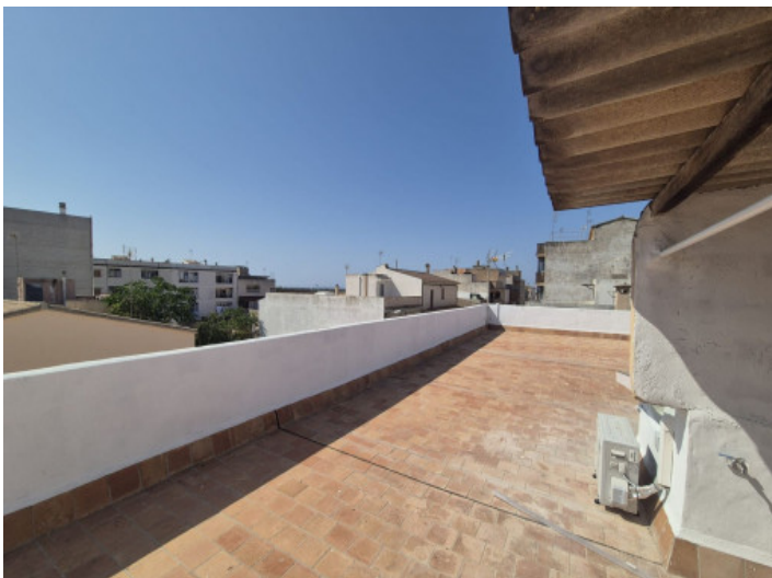
Terraza en la azotea
