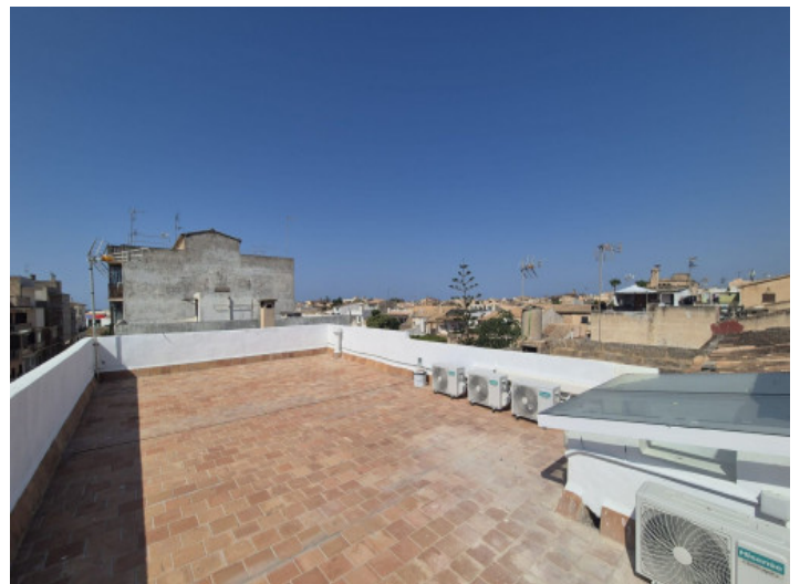
Terraza en la azotea
