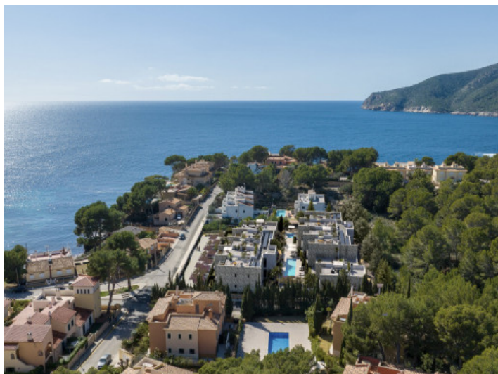
Vista sobre el complejo
