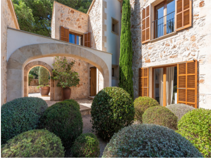
Zona exterior de la villa
