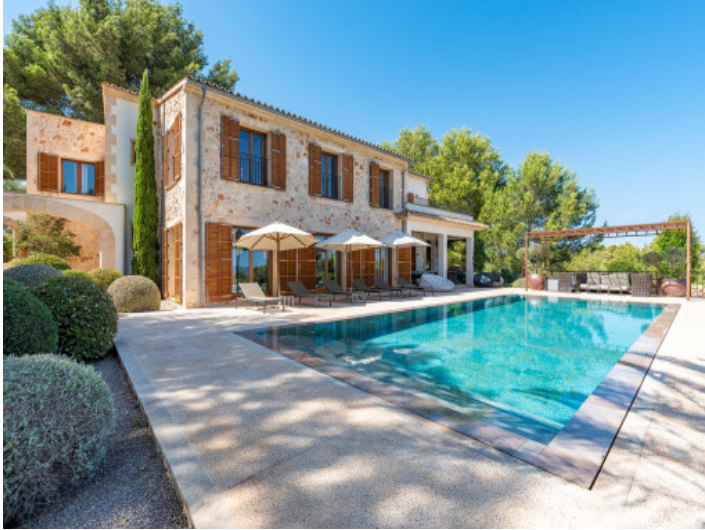
Vista exterior de la villa
