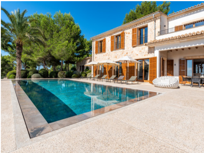
Vista exterior de la villa
