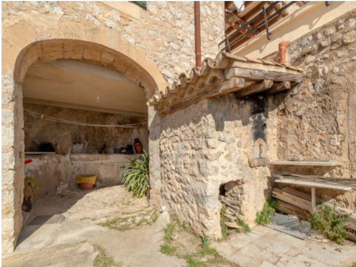
Área exterior con horno
