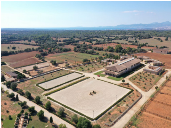
Instalaciones y establos de hipismo de lujo
