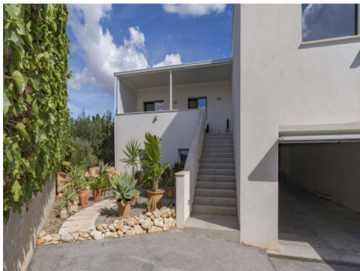
Entrada a la casa y garaje
