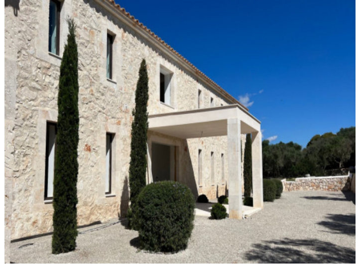
Fachada de piedras naturales
