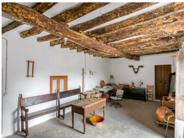
Cuarto con vigas de madera
