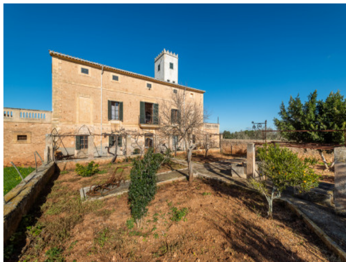
Vista exterior de la finca
