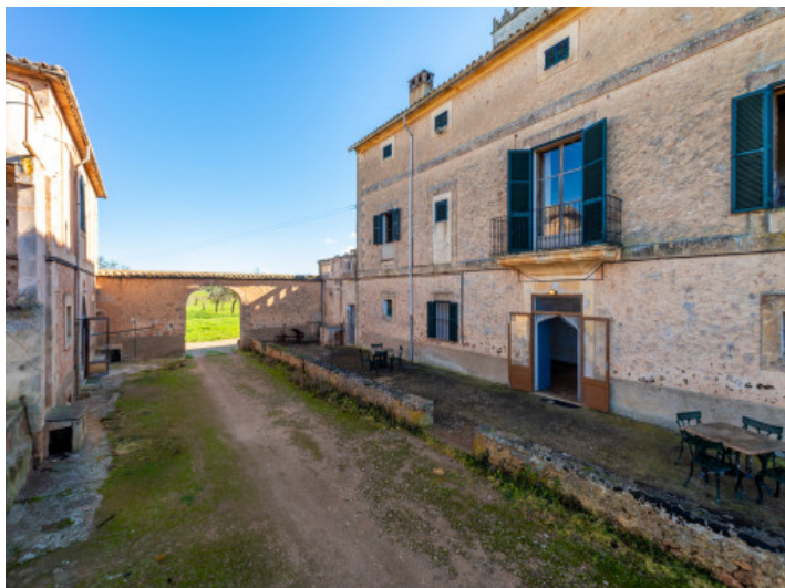
Vista exterior de la finca
