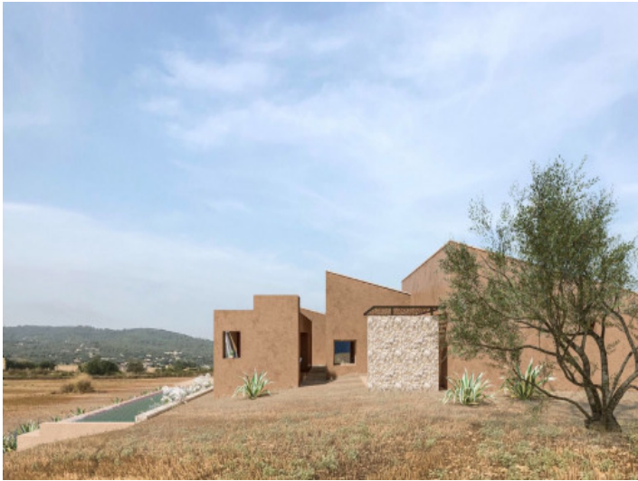
Vista exterior de la finca
