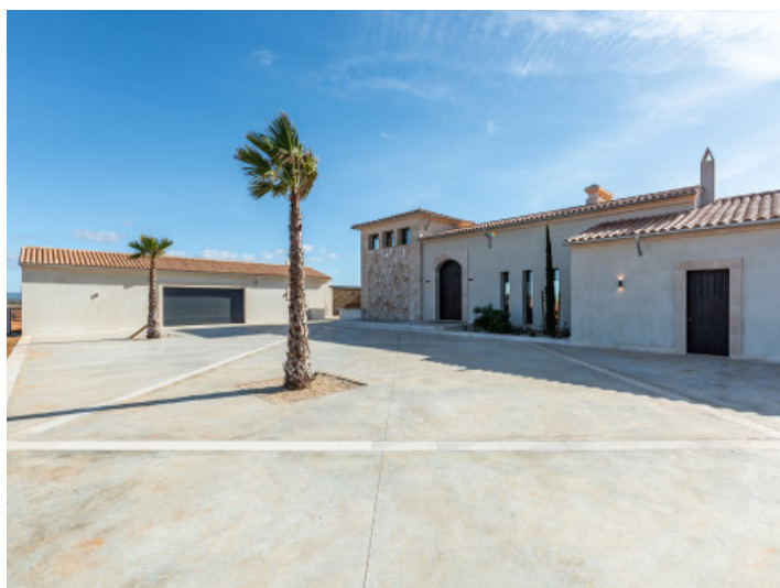
Vista frontal y garage
