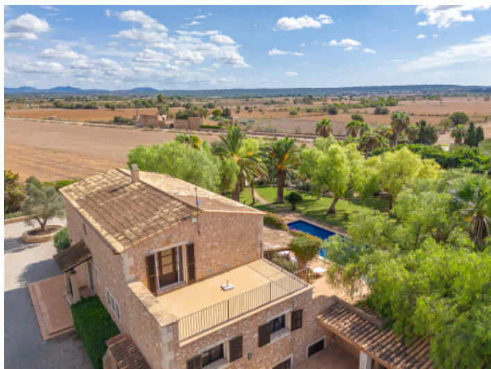
Fachada de piedra natural
