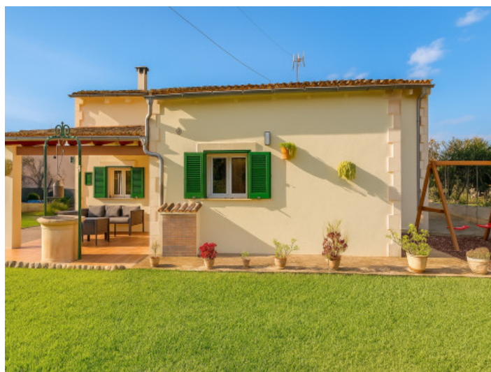
La vista frontal con la zona de acceso
