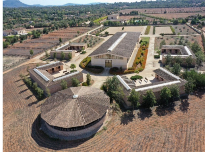
Instalaciones y establos de hipismo de lujo
