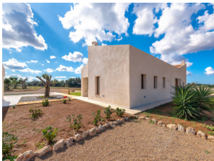
Vista exterior entrada
