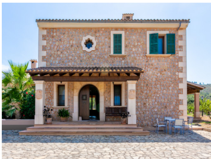
Vista frontal de la finca de piedra natural
