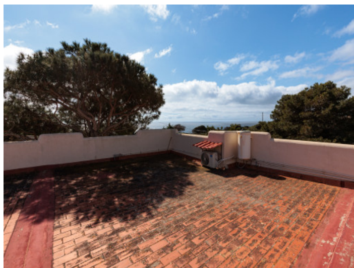
Terraza en la azotea
