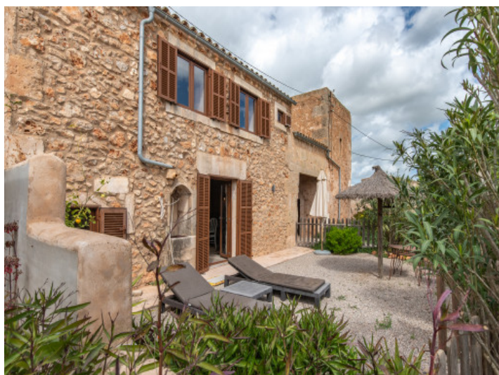
Edificacion con dos apartamentos
