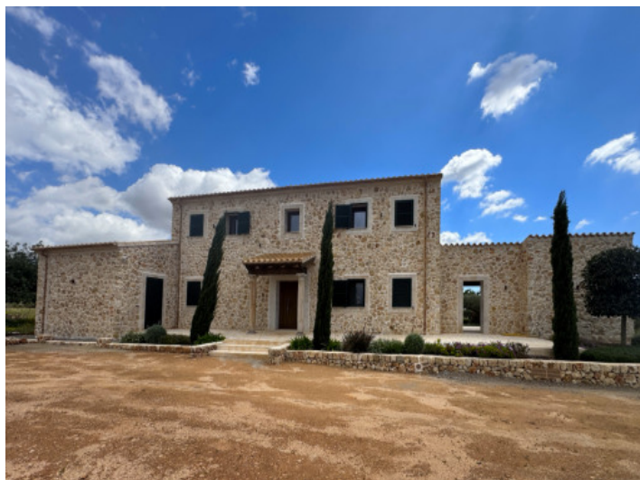
Finca Llucmajor Fachada
