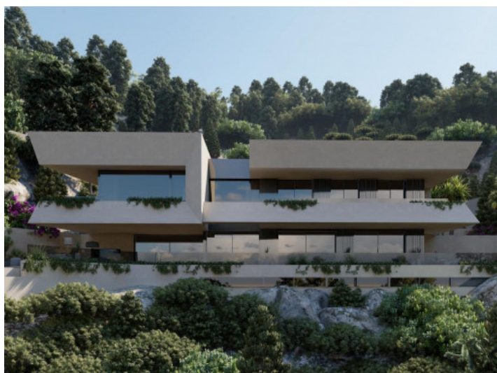
Vista exterior de la villa
