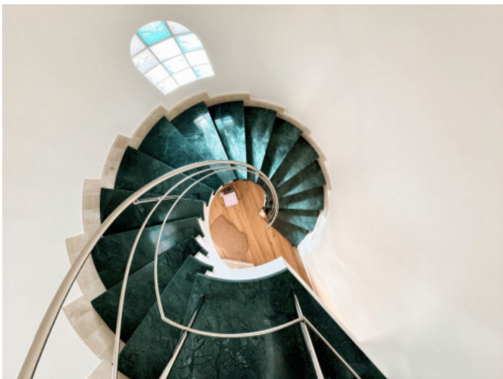
Escalera de caracol
