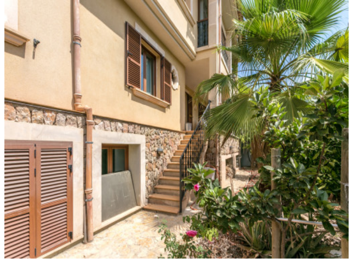
Vista lateral y zona exterior
