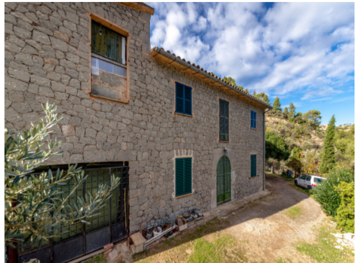
Fachada de piedra natural
