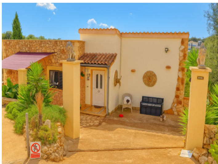
Fachada trasera con entrada principal
