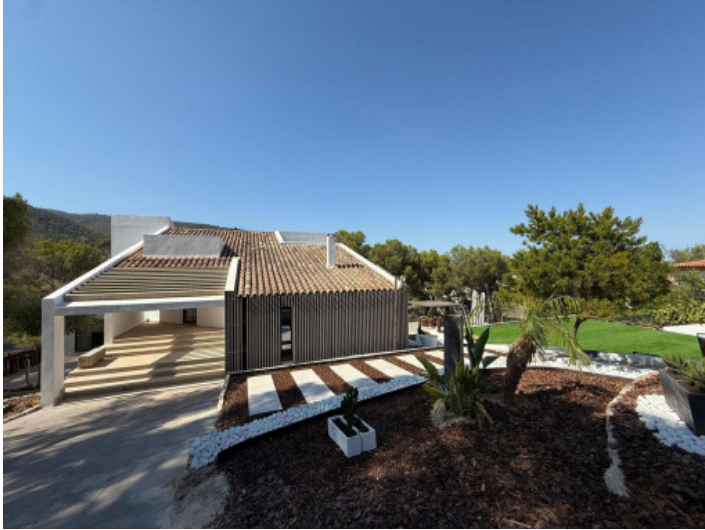
Zona exterior mediterránea con varias terrazas, diseñada de forma
