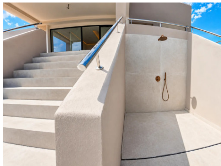
Escalera exterior de acceso a la terraza superior
