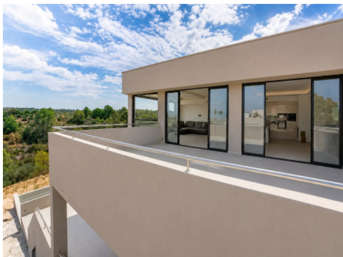
Fachada moderna de la villa con un amplio balcón
